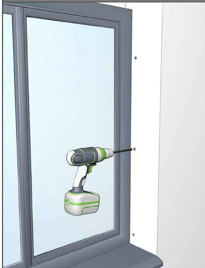
**9** Passer la manoeuvre du volet roulant dans le dormant (ou le mur pour le cas d'une pose applique) et repositionner l'ensemble du volet roulant.
